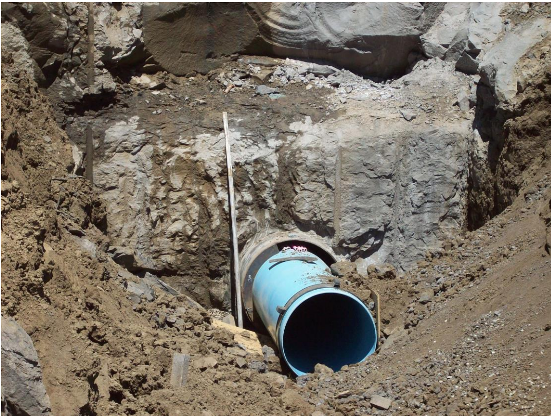
Instalacja rury przewodowej (najczęściej centrycznie na ślizgach) i ewentualne wypełnienie przestrzeni pierścieniowej wypełniaczem.
