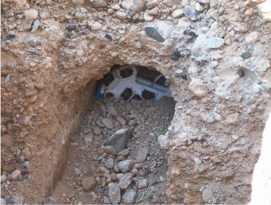
Przewiert rurą stalową osłonową zakończony...
