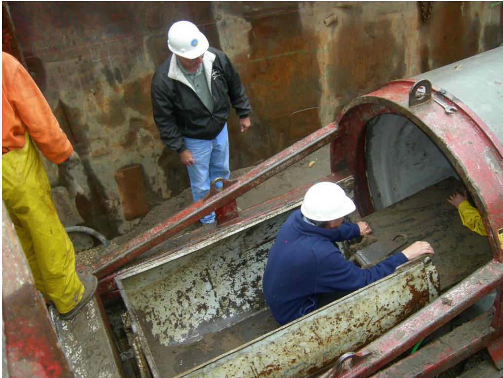
Wjazd do maszyny TBM-1200 na odległość około 120 m
