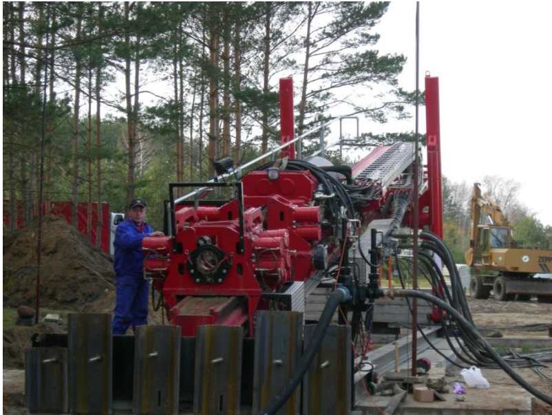
Krzysztof Kalisiewicz z firmy Marpol na tle dostarczonej wiertnicy HDD o sile ciągu 160 ton siły ciągu
