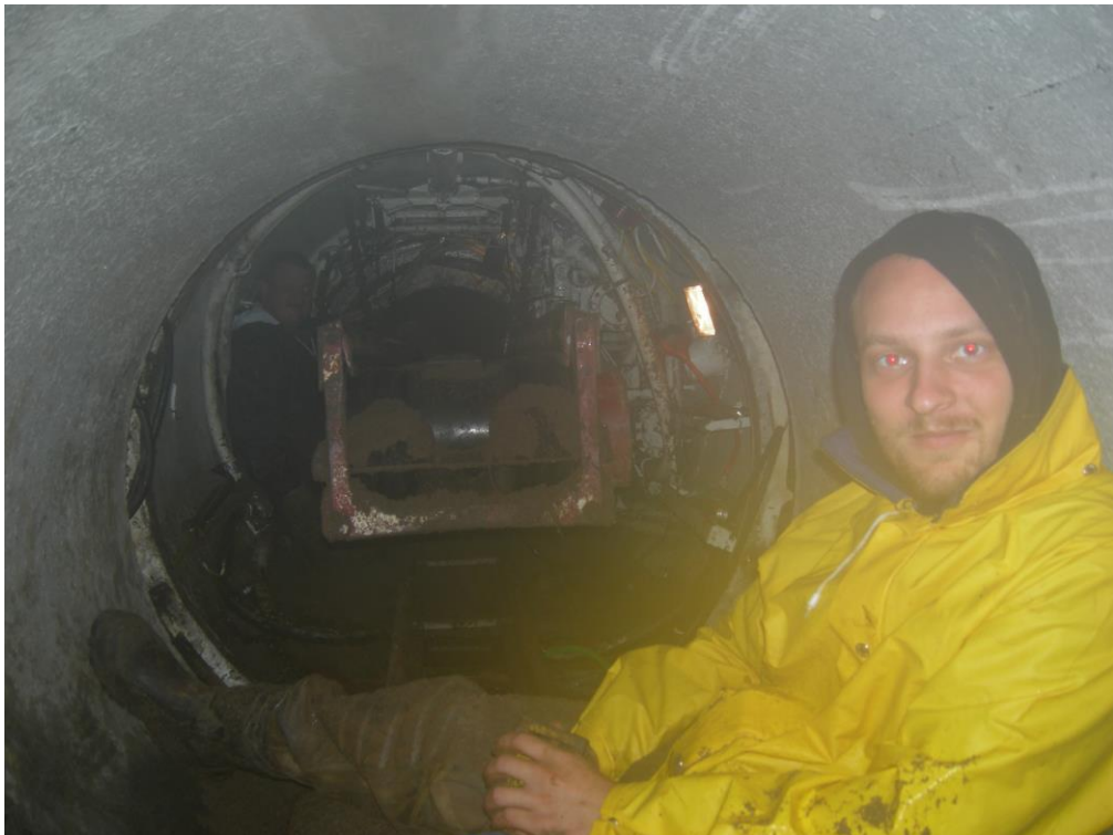
Operator systemu wewnątrz maszyny TBM (zdjęcie własne wykonane przez autora na odległości 120 m od komory)
